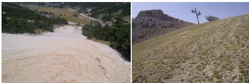
Figure 8 : Piste nue après travaux (Station Gréolières les Neiges) □ rendu après 3 hydroseeding coréalisés avec l'ONF
