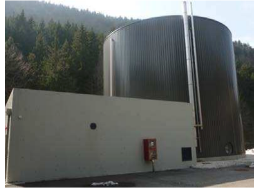
STEP de Fénat à Villard de Lans, méthaniseur des boues et du lactosérum
