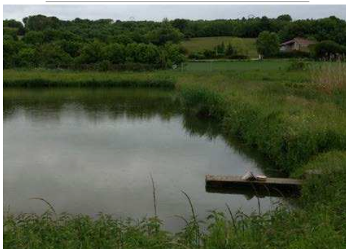
Figure 9 : Photo de gauche : répartition des stations d'épuration selon les filières de traitement - photo de droite : système de lagunage de Charatonnay (38)
