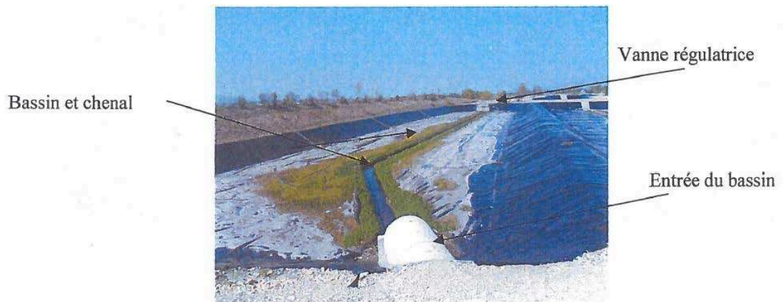
Figure 15 : Bassin de décantation des eaux pluviales de Brézins
