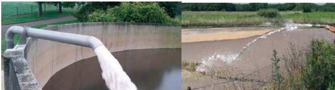
Figure 43 : Photo de gauche : chaulage de boues liquides dans un silo épaisseur □ Photo de droite : chaulage de boues de lagunage (source : Neutralac)
